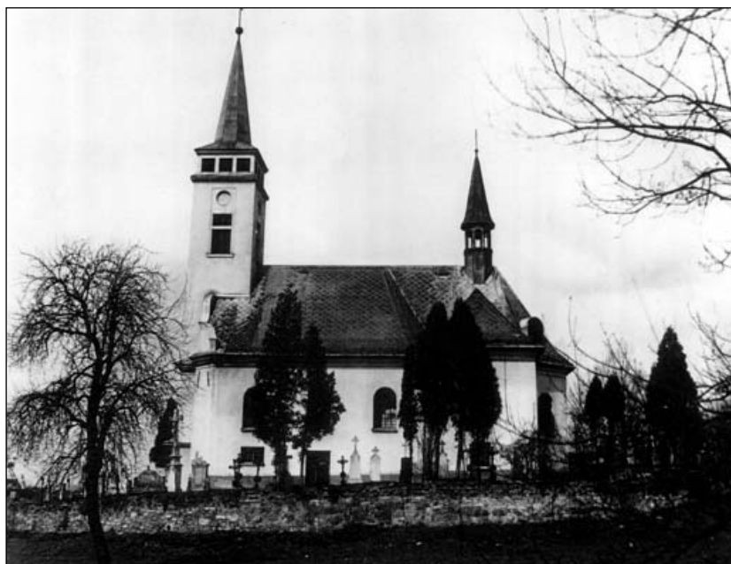
Pohled na kostel Navštívení P. Marie v Soběšovicích, dnes zatopeno Žermanickou přehradou, 1954 Sbírka D. Pindura
