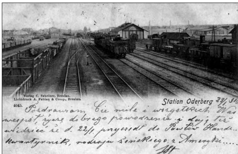
Pohled na kolejistiště nádraží v Bohumíně v r. 1905
