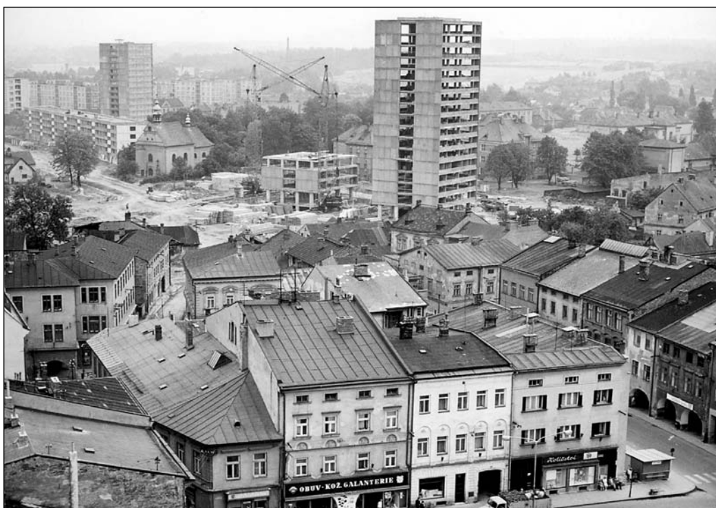
Výstavba sídliště Riviéra, Frýdek-Místek, 1975 Foto Jan Byrus
