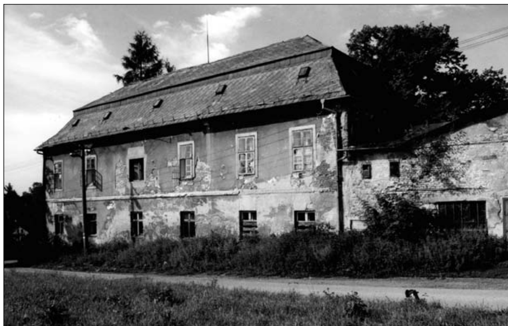
Zámek od východu. Na severní straně se k barokní stavbě připojují zmodernizované a zpusťlé hospodářské budovy.
