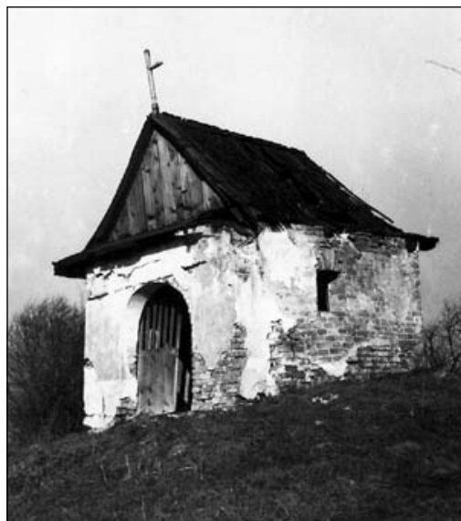
Zámecká kaple v Horních Domaslavicích před rekonstrukcí r. 1960 Archiv autora Foto Jan Š. Zaškolný
