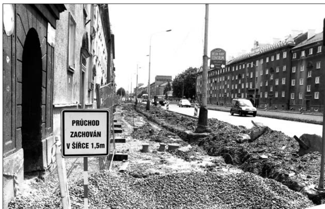
Chodník na Hlavní třídě v průběhu rekonstrukce – červenec 2008 Foto Jiří Kristian
