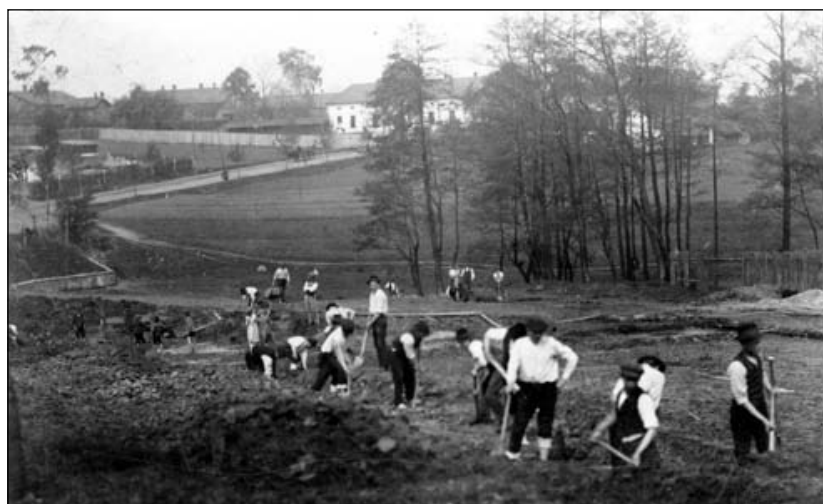
Kopání základů pro Lidový dům, r. 1919, archiv Jana Steinera
