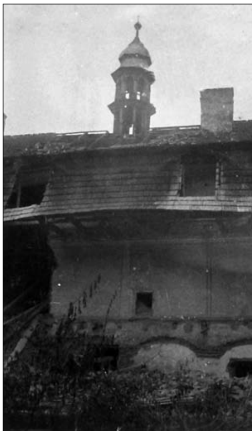
Unikátní snímek dokumentující demolici šenovského sídla Skrbenských z Hříšti, r. 1927, Státní okresní archiv Frýdek-Místek
