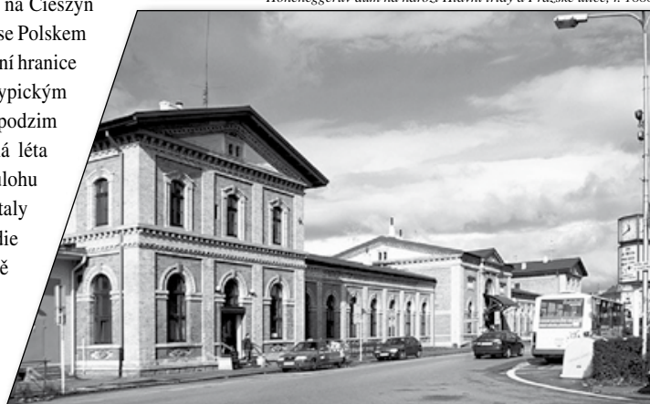
Železniční stanice, r. 2008
