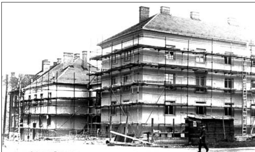
Výstavba obytného domu na nároží Gymnazijní a Komenského ulice, r. 1957, Muzeum Těšínska
