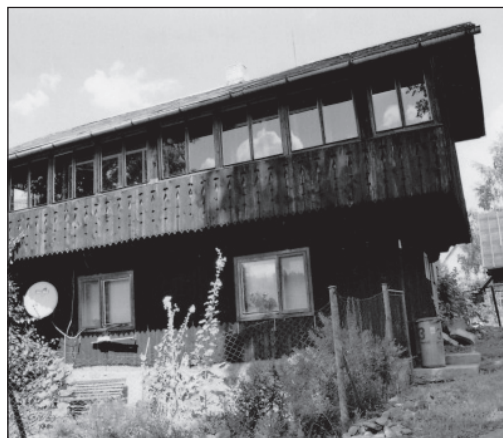
Obytný dům č. p. 223 v Písku s dřevěnou konstrukcí z bývalého loveckého zámku Plenisko, r. 2010, foto František Musil
