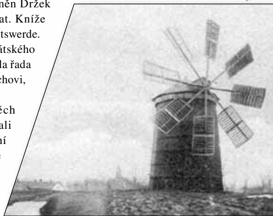
Větrný mlýn nedaleko centra Dolní Lutyně, r. 1905
