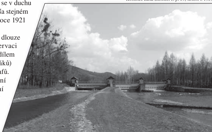
Jez Vyšní Lhoty oddávající přiváděč (vlevo) od toku Morávky, r. 2013
