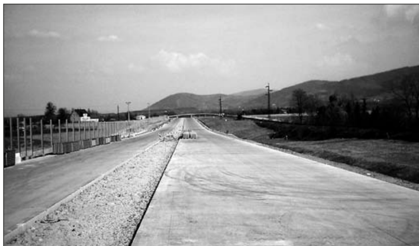
Výstavba silnice R48 v Nošovicích v sousedství železniční trati Frýdek- -Místek–Český Těšín (stav před dokončením a výstavbou průmyslové zóny s továrnou automobilky Hyundai), 22. dubna 2006, foto David Pindur
