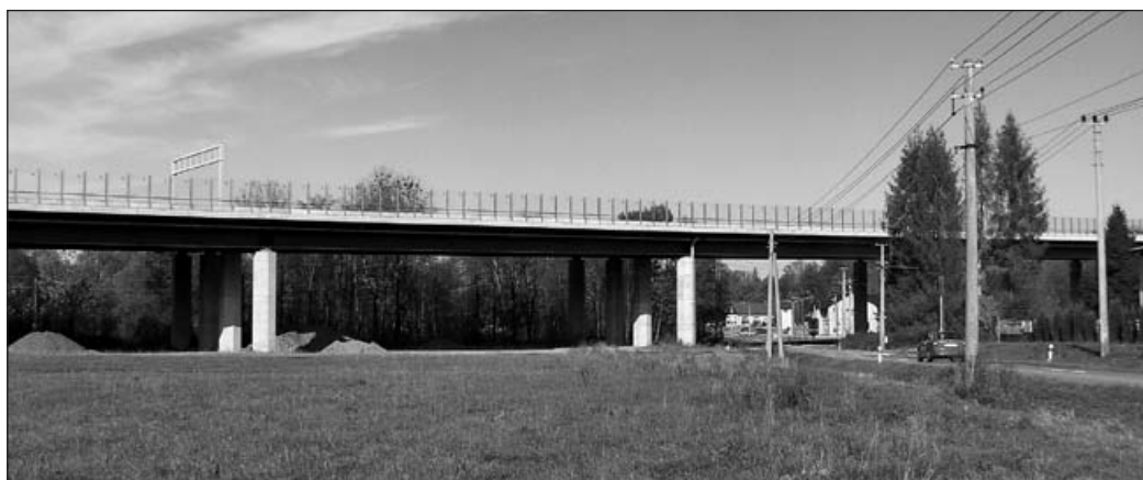
Estakáda silnice R48 v Třanovicích, v těsné blízkosti centra obce řeší přemostění říčky Stonávky. Tento způsob zároveň umožňuje zachování přirozeného biokoridoru, r. 2013, foto Daniela Podstawková
