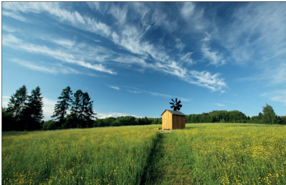
Obnovený větrný mlýnek ve Václavovicích (ul. Vratimovská), foto Miroslav Lysek
