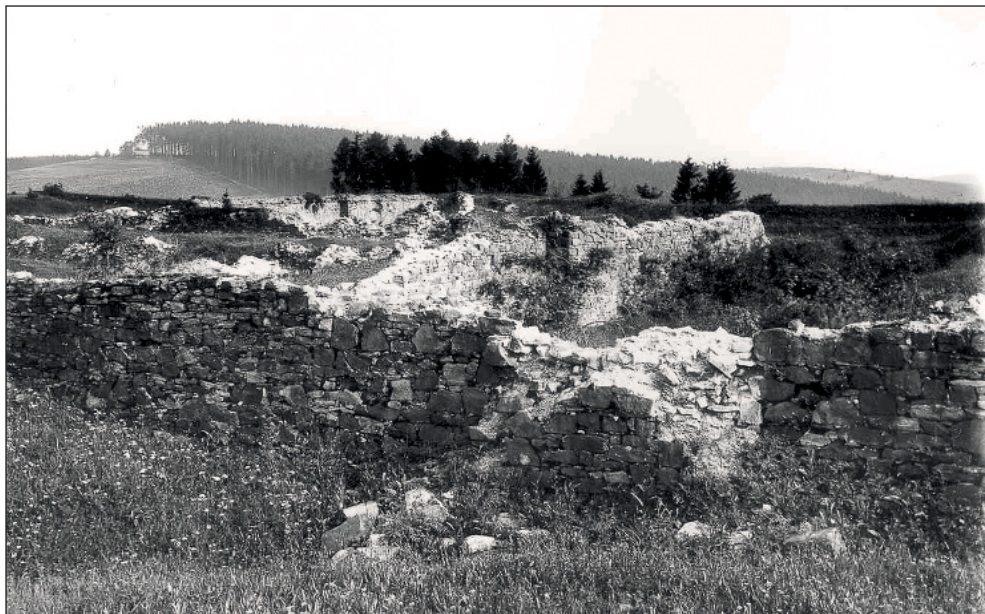
Destrukce kamenného zdiva objektů (tzv. blockhauzů) v západní části areálu Velké šance v Mostech u Jablunkova, kolem r. 1910, Muzeum Śląska Cieszyńskiego
