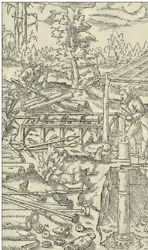
Ukázka z díla Georgiuse Agricoli s využitím vertikálního a horizontálního způsobu vrtání podélných vývrtů v kmelech stromů, převzato z Agricola, Georg: De Re Metallica Libri XII . Basilea 1556
