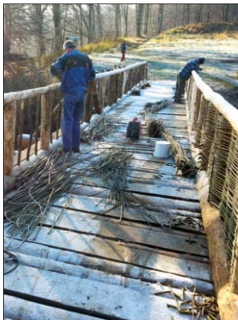
Oprava mostu v Archeoparku, podzim 2015, Muzeum Těšínska
