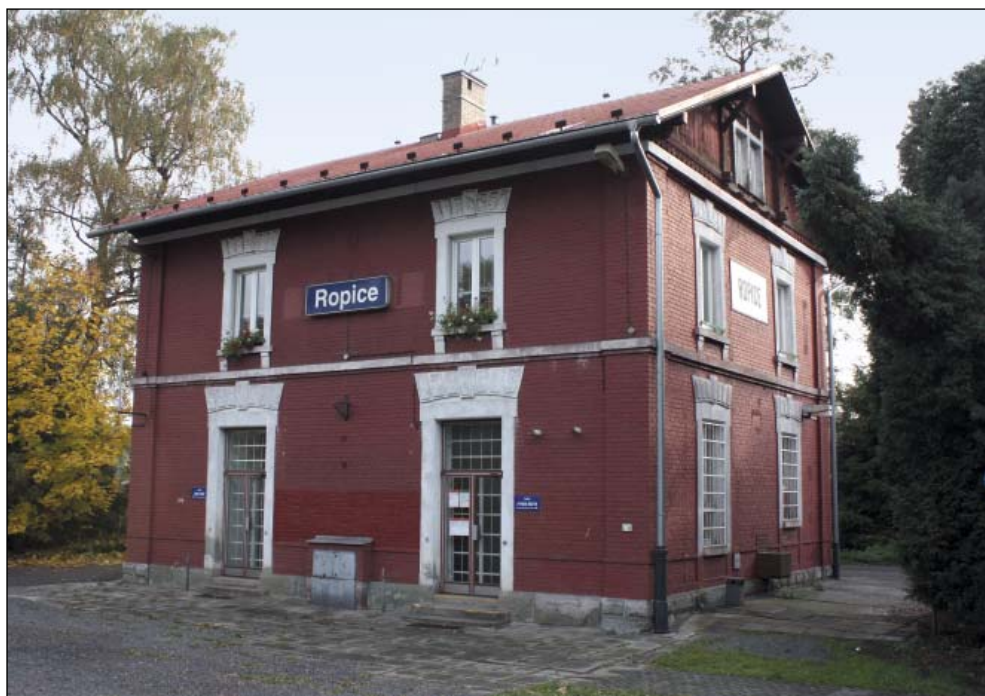
Budova nádraží, r. 2016, foto Radim Jež
