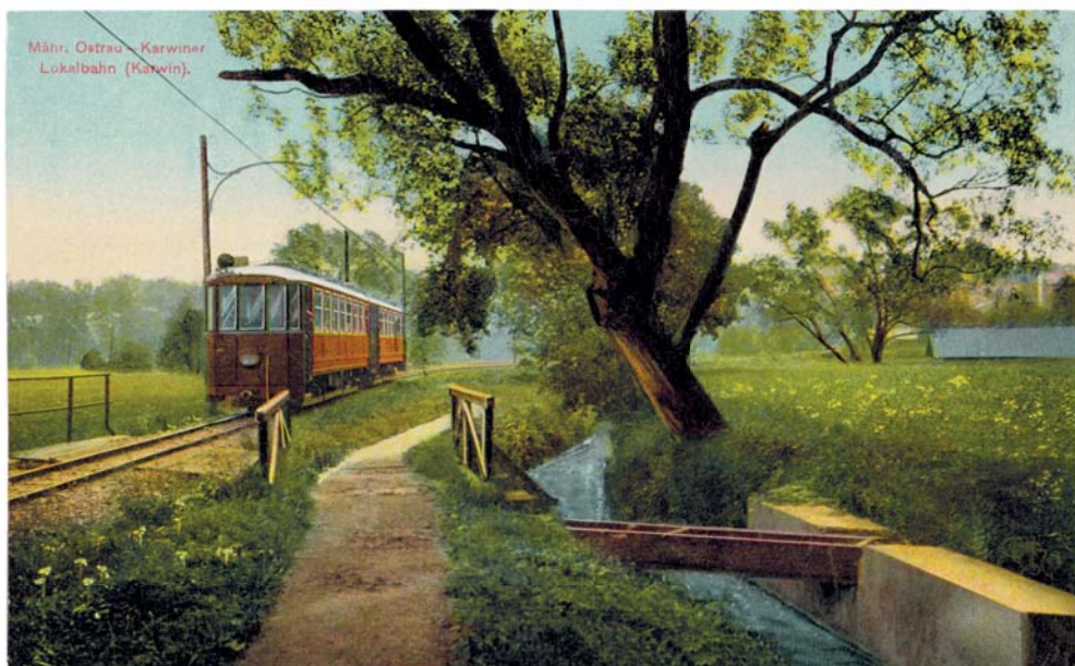
Záběr z karvinského úseku úzkorozchodné trati spojující od r. 1909 Karvinou s Moravskou Ostravou, r. 1911, Muzeum Těšínska
