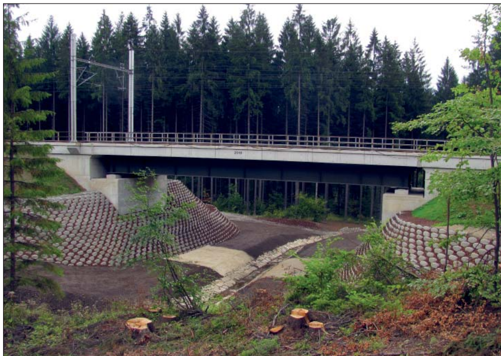
Migrační podchod pod železnici na koridoru Celnice, foto Tomáš Krajča
