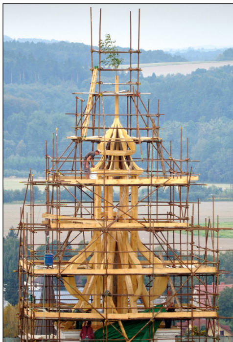
Rekonstruovaný krov zámekské věže na začátku září 2016, foto Marek Weissbrod
