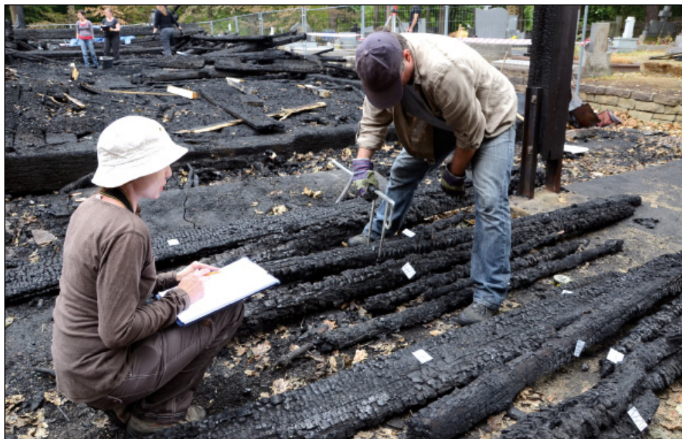
Dokumentální práce na spáleništi kostela Božího těla v Gutech 17. srpna 2017, foto Gabriela Čočková
