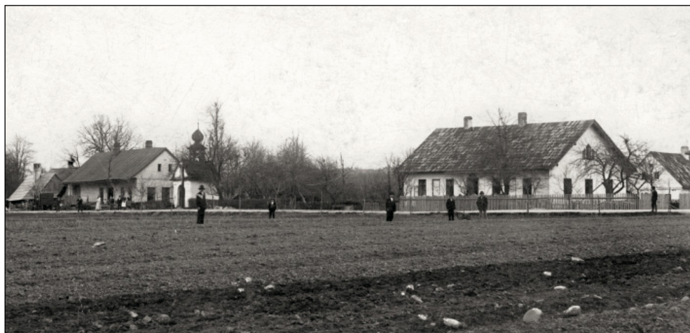
Budova školy v Prácheň postavená v r. 1873. Vyučovalo se v ní do poloviny r. 1927. Vlevo obecní kaple Panny Marie z r. 1837, na jejímž místě byl v letech 1910–1911 postaven kostel Neposkvrněného početí Panny Marie, kolem r. 1905, archiv Ludmily Mališové
