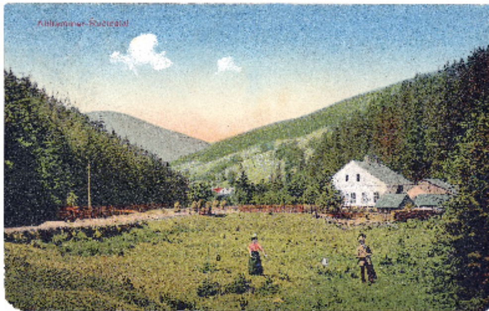
Budova jednotřídní školy ve starohamerském údolí Řečice postavená v letech 1892–1893, r. 1911, archiv Davida Pindura
