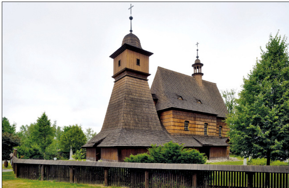
Kostel sv. Kateřiny v Hrabové po dokončení rekonstrukce, foto Roman Polášek
