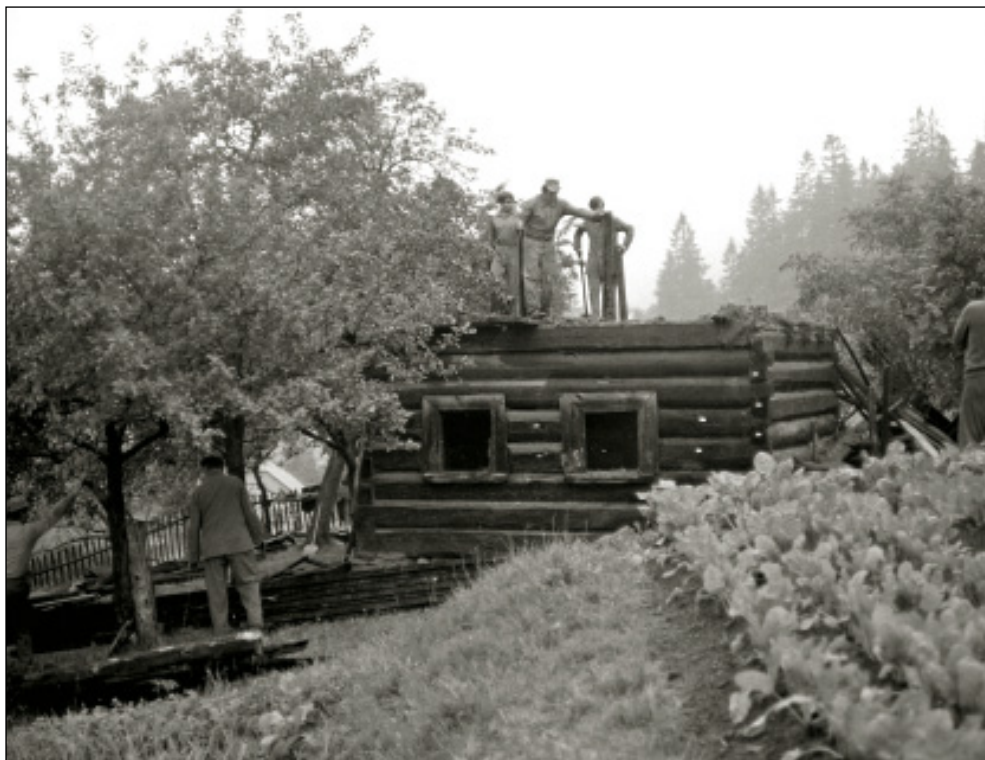
Demontáž stavby, r. 1975, Valašské muzeum v přírodě v Rožnově pod Radhoštěm, foto Marie Baďuřiková
