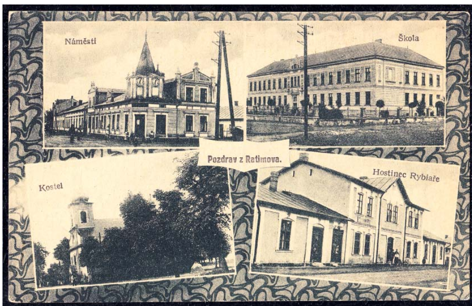
Světlotisková pohlednice Vratimova vydaná Josefem Borůvkou z Přívozu zobrazuje i dva podniky Františka Rybíaře – objekt obchodu smíšeným zbožím s charakteristickou hodinovou věží (č. p. 147) a dnes již neexistující nedalekou budovou hostince (č. p. 40), r. 1920
