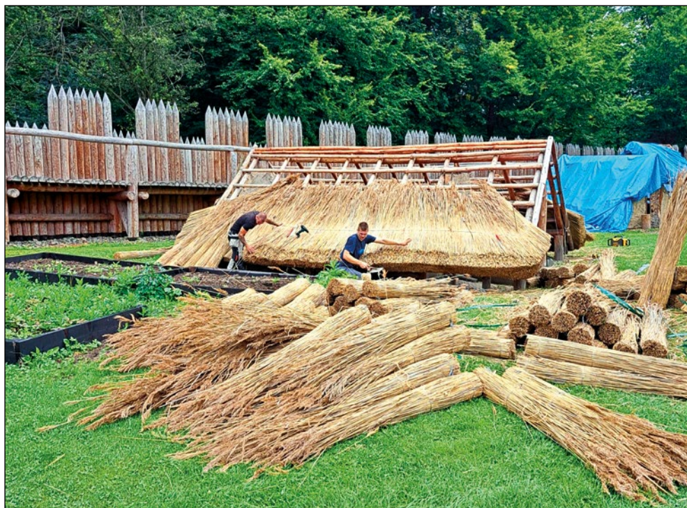
Oprava rákosových střech tří staveb v Archeoparku Chotěbuz-Podobora, 5. srpna 2024, foto Lenka Ježová Bichlerová
